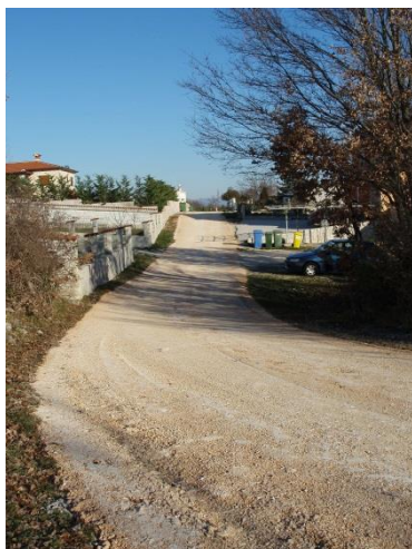
Započela izgradnja vodovodnog ogranka Salakovci
