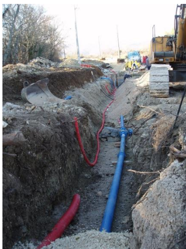
Izvršena rekonstrukcija vodovodnih cijevi unutar naselja Presika
