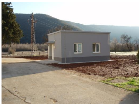
Izgradnja crpne stanice Rahonek
